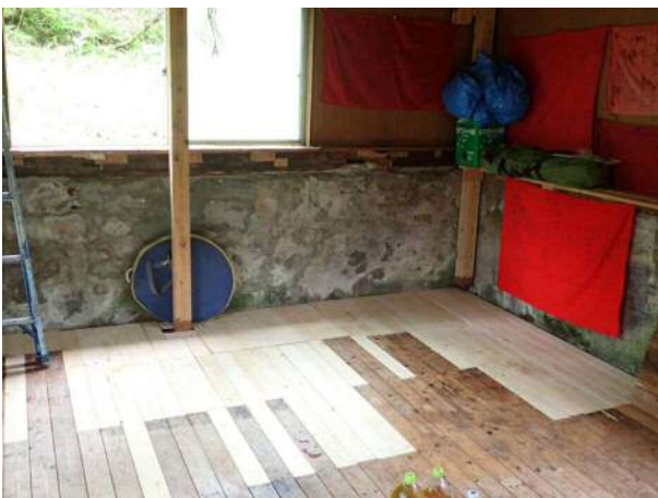
床補修（一部張替）
