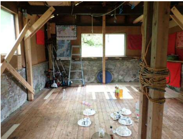
修繕後（床）の屋内
