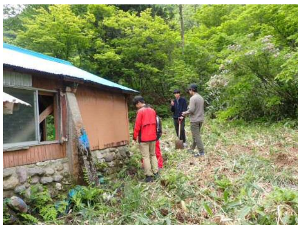
水廻り側溝整備
