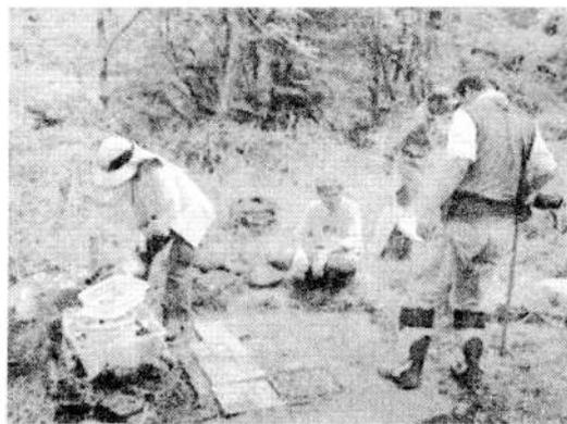
石段の整備はなかなかの重労働である。河原から平面的な石を運びあげ、それを埋める適当な穴を掘り安定するように調整しなければならない。素人の俄か作業にしては出来栄はまずまずだが、雨が降るとどうなるかかなり心配ではある。
