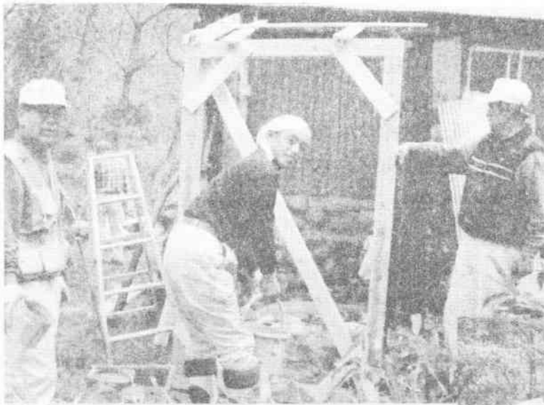
着々と仕上がっていくトイレ 13期大島 13期辰野 13期吉本
