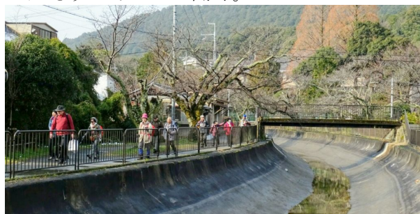
＜疏水第五橋：三角橋となっている＞
