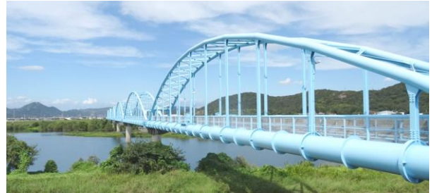
加古川に架かる水管橋
