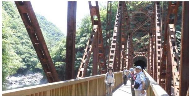
『武庫川第2橋梁』と『溝滝尾隧道(後方)』
