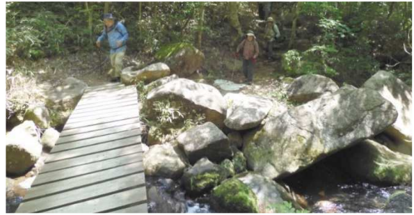
『布引谷』上流の傾いたまま架けられている橋
