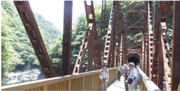
『武庫川第2橋梁』と『溝滝尾隧道(後方)』
