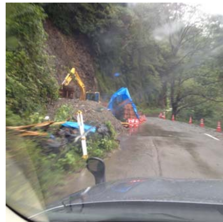
県道207号線の工事現場、いつ終わるのだろうか？
